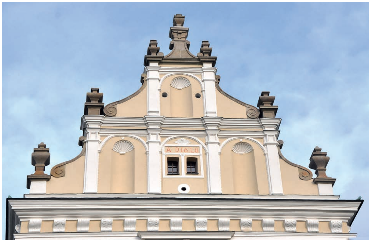
VI/103. Leżajsk. Timpano della facciata principale della chiesa dei Padri Bernardini con le feritoie.
