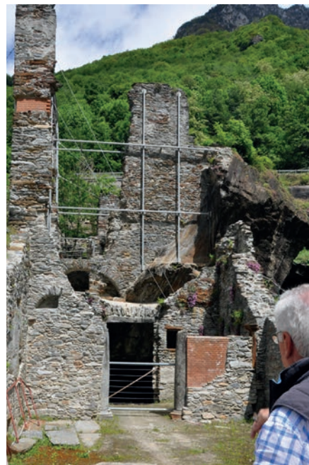
I/38. Piuro. Rovine del palazzo di Belfort.
