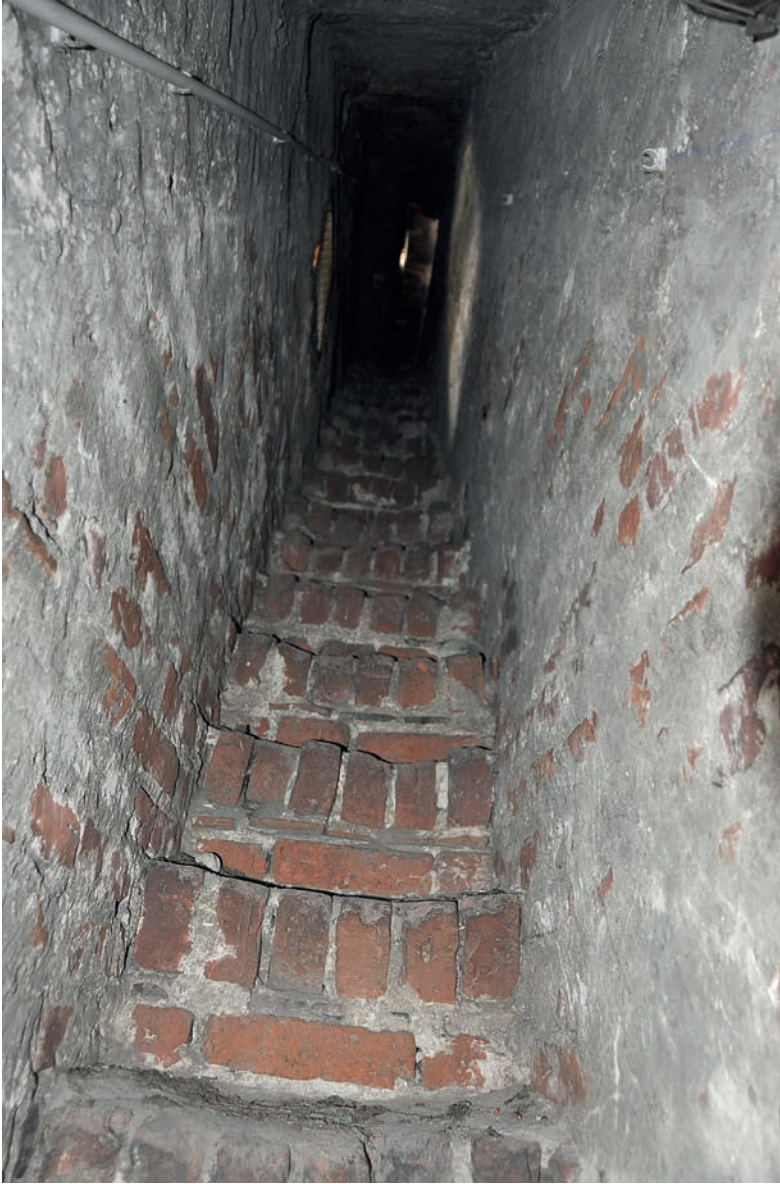
VI/105. Ležajsk. Corridoio celato all'interno del muro della facciata occidentale che unisce il matroneo settentrionale a quello meridionale.
