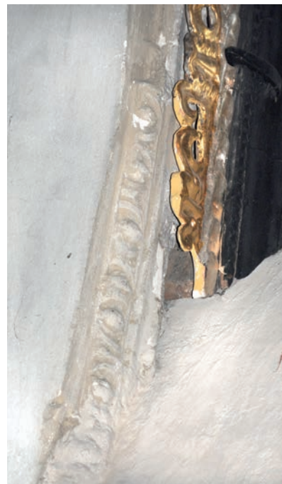
VI/48. Leżajsk. Interno della chiesa. Dettaglio della modanatura dello stucco nella navata settentrionale.
