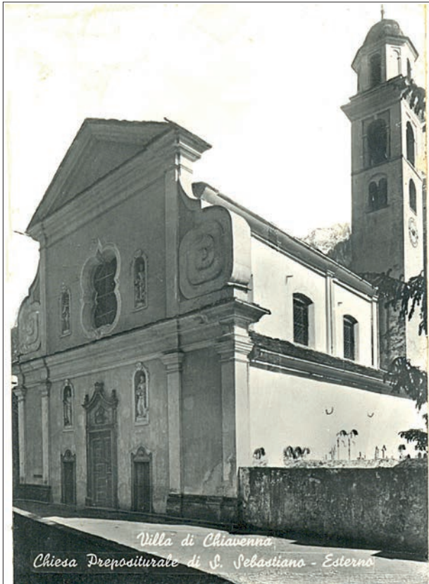
I/23. Villa di Chiavenna. Chiesa di S. Fabiano e Sebastiano dopo la ricostruzione dell'inizio del XVIII secolo. Vista della facciata e della parete meridionale.
