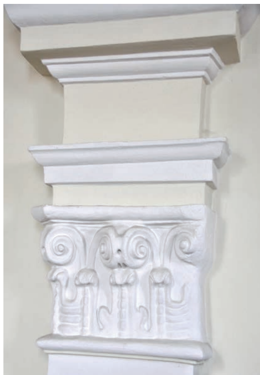
VII/99. Hrodna. Interno della chiesa delle Suore Brigidine – dettaglio della trabeazione e del capitello della parasta.
