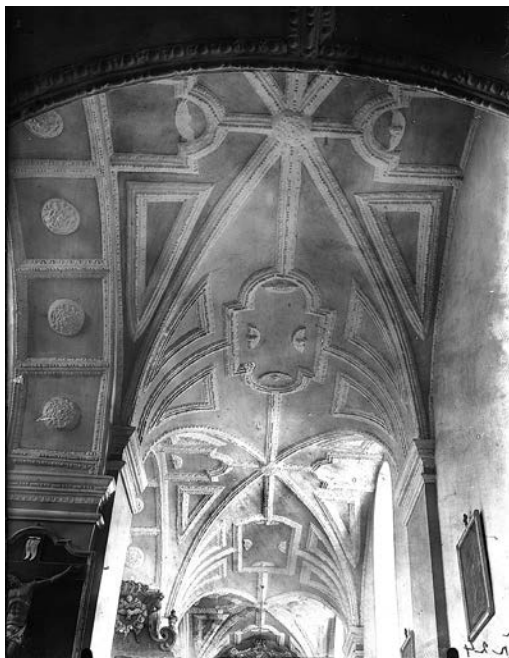
VII/114. Druya. Interno della chiesa dei Padri Bernardini – decorazione a stucco sulla volta della navata laterale.
