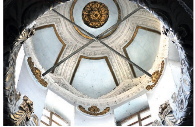
VI/63. Leżajsk. Chiesa dei Padri Bernardini, cappella di San Francesco – dettaglio della decorazione a stucco nella lanterna.
