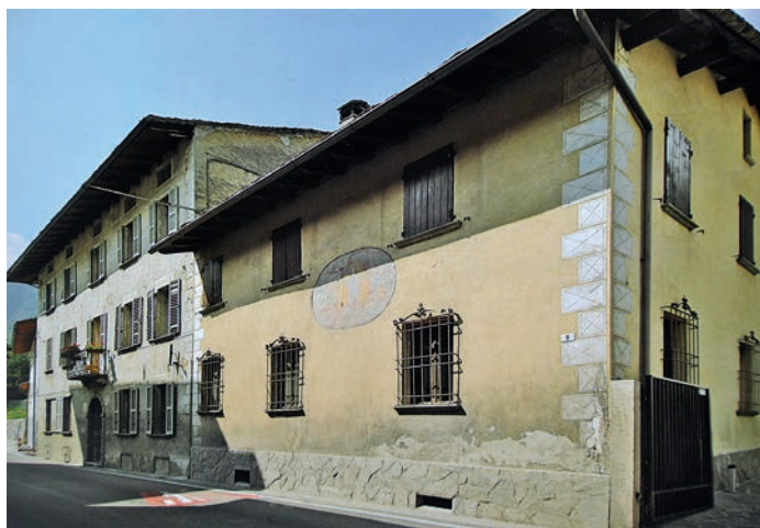
I/11. Prosto di Piuro. Palazzine rinascimentali della fine del XVI secolo.
