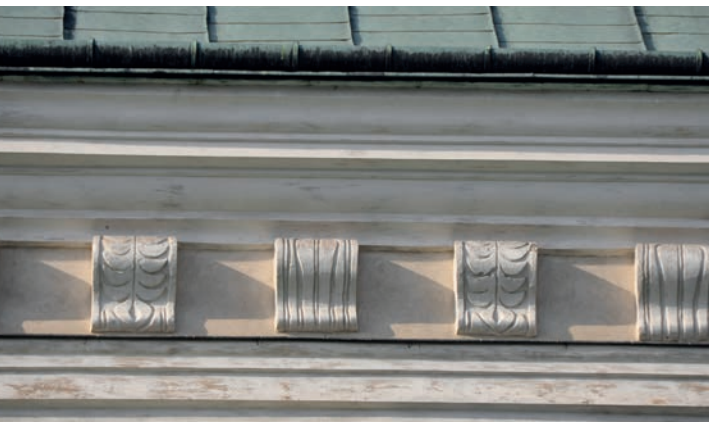
VI/32. Leżajsk. Dettaglio della trabeazione della navata centrale con il fregio a consolle .
