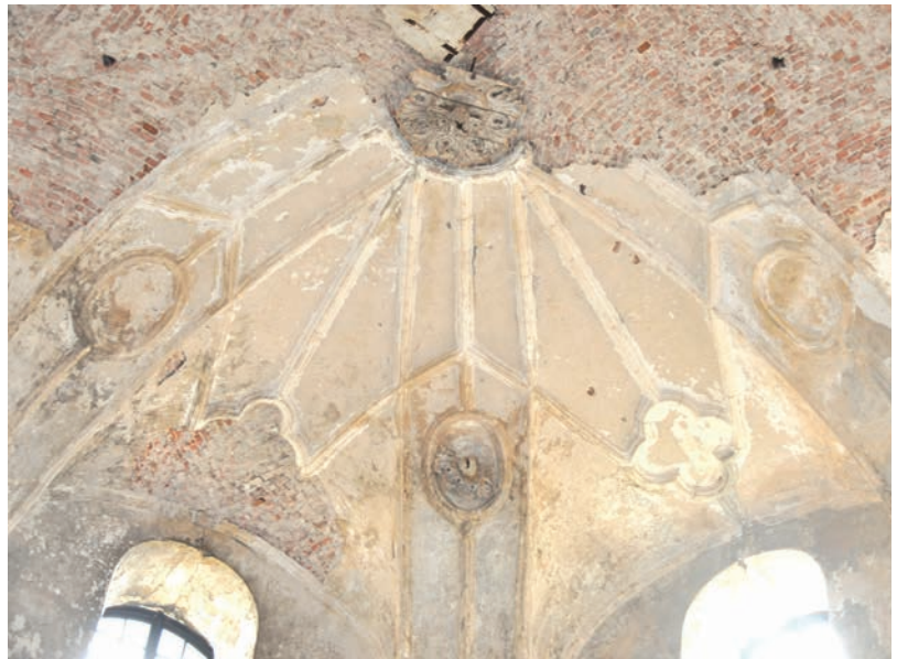
VII/35. Olyka. Interno della collegiata – volta dell'abside, 2014.
