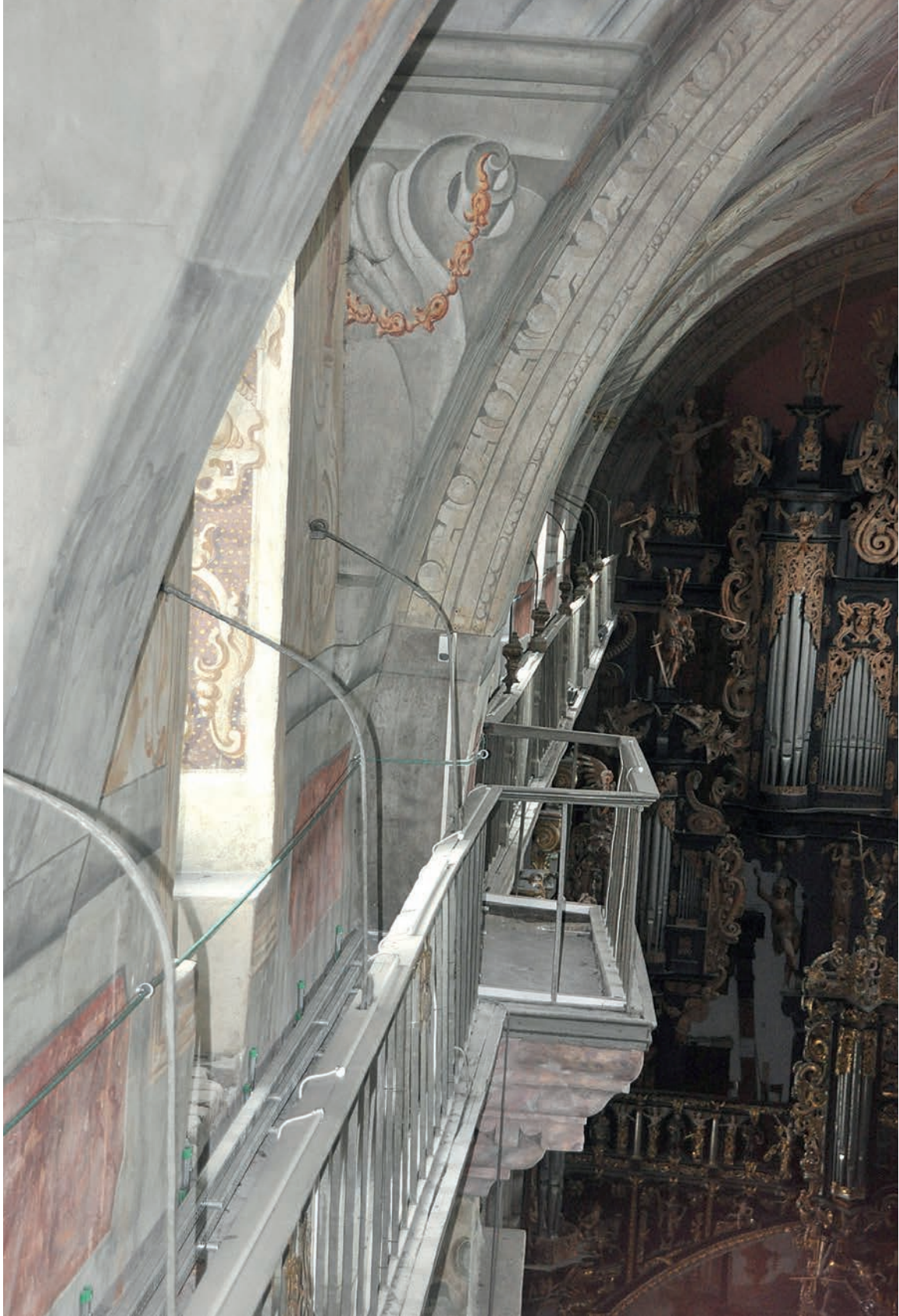
VI/104. Ležajsk. Matroneo che crea un passaggio di comunicazione all'altezza delle finestre superiori.
