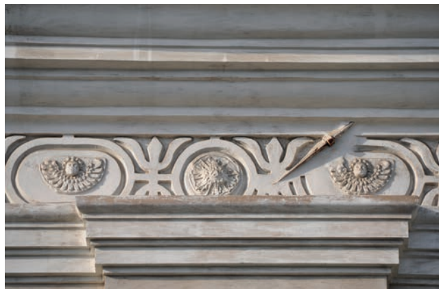
VI/33. Leżajsk. Dettaglio della trabeazione della navata laterale-meridionale con l'ornamento cuir découpé .
