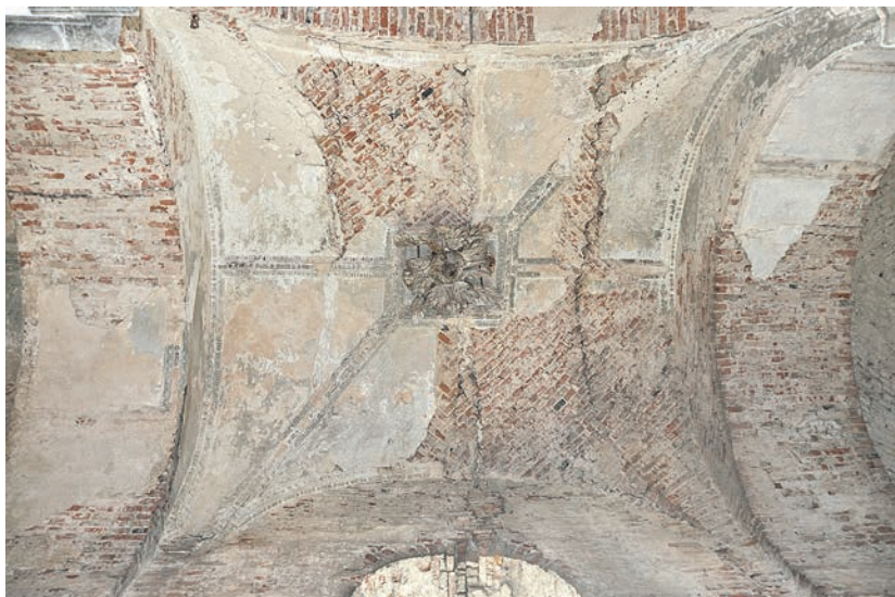
VII/36. Olyka. Interno della collegiata – volta nella navata laterale con gli archi rampanti, 2014.
