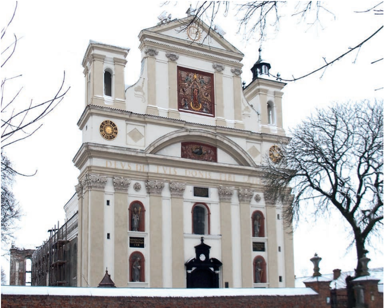
VII/49. Olyka. Facciata della collegiata dopo i lavori di conservazione (ad eccezione del coronamento della torretta sinistra), 2019.
