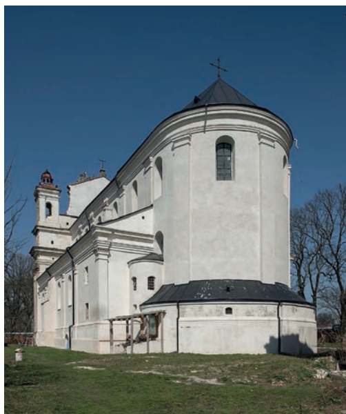
VII/46. Olyka. La collegiata vista da est, dopo la ristrutturazione, 2018.
