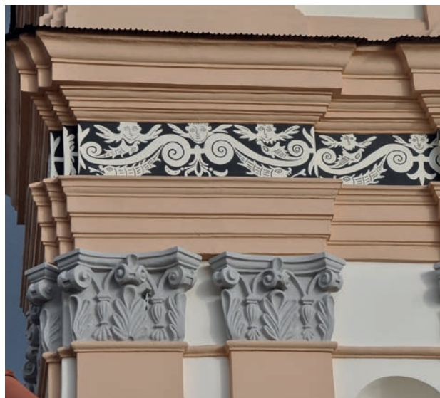
VII/102. Hrodna. Facciata della chiesa delle Suore Brigidine – dettaglio della trabeazione con lo sgraffito e i capitelli a stucco dei pilastri.
